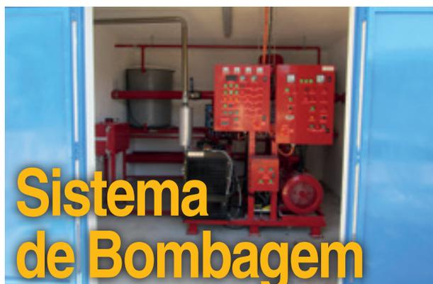
A Associação dos Lares Ferroviários instalou recentemente no Lar do Entroncamento um sistema de bombagem e depósito privativo para serviço de incêndio para alimentação da rede de incêndio armada existente no edifício.
